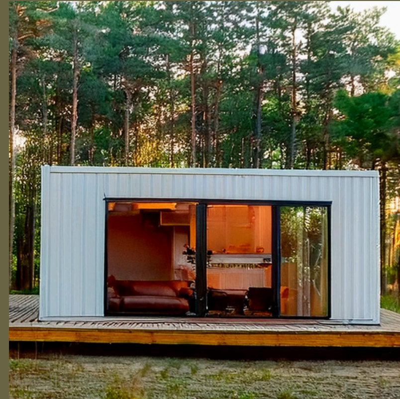
Terminación Chapa Blanca
