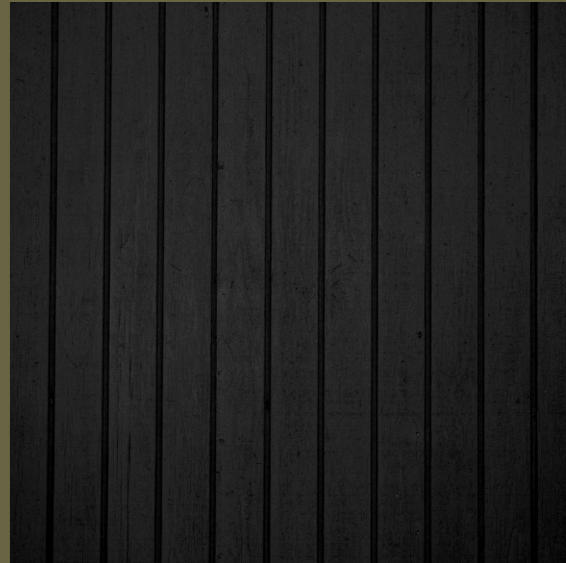
Terminación Exterior Símil Madera Negra
