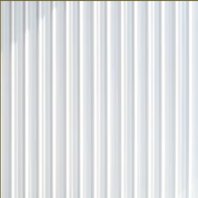
Terminación Exterior Chapa Blanca
