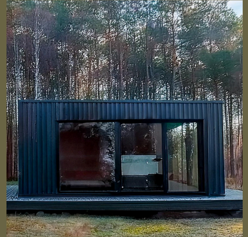
Terminación Chapa Negra
