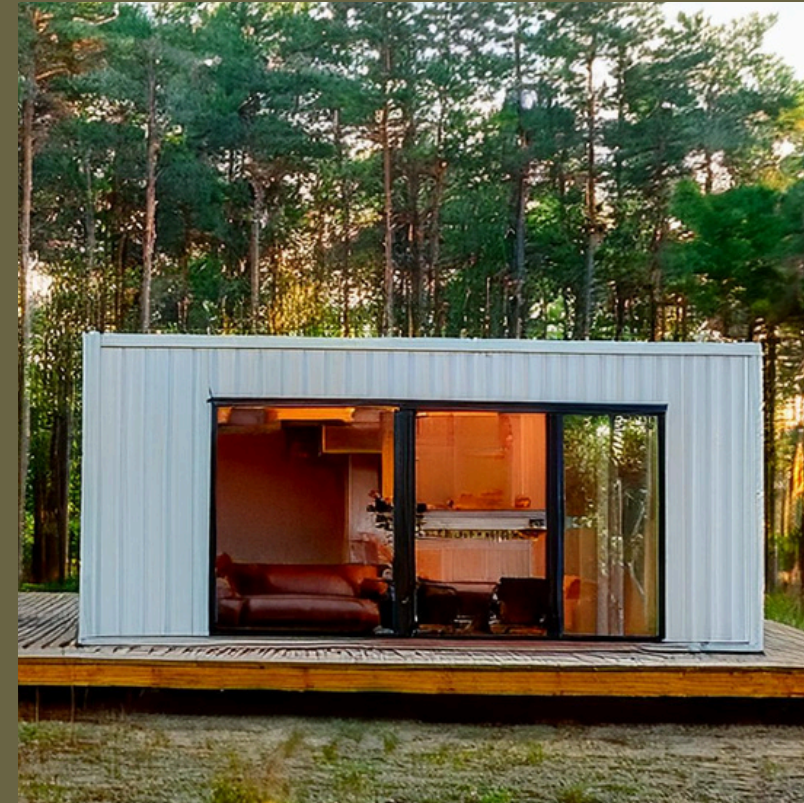
Terminación Chapa Blanca
