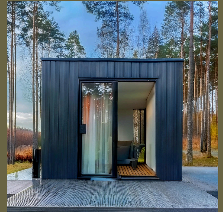
Terminación Chapa Negra
