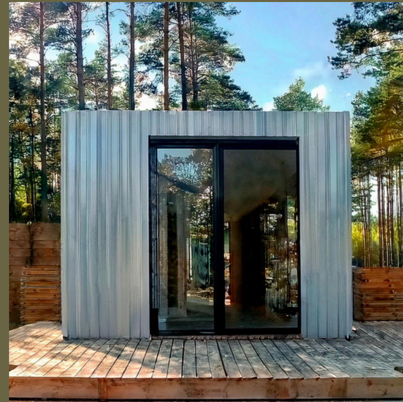
Terminación Chapa Blanca
